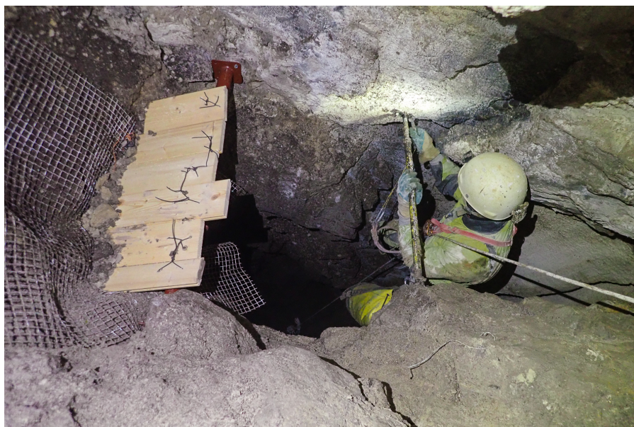
◁ Après de multiples tentatives la solution la plus simple pour contenir les chutes de pierres sera trouvée en réalisant un barrage en planches soutenu par un étai de maçon.
